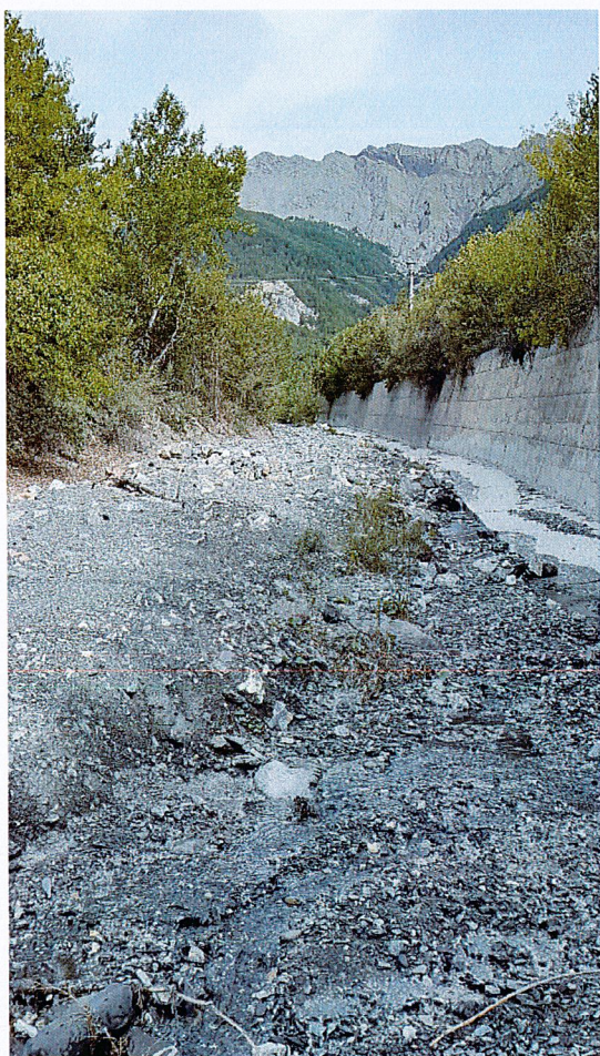
Photo 1 : Vue de la ripisylve et du cours d'eau à l'amont de la zone de chantier
