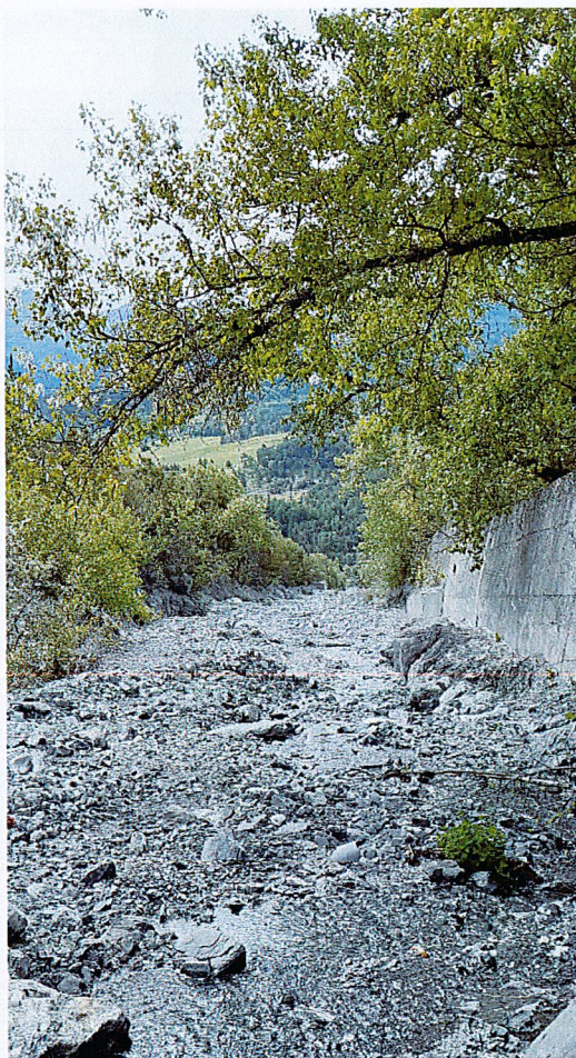
Photo 2 : Vue de la ripisylve et du cours d'eau à l'aval de la zone de chantier
